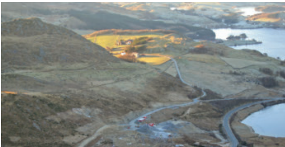
Den nyeste næringsparken i Stavanger-regionen ligger i Gjesdal kommune. I 2007 vil første felt være klart. Da vil også innkjørsler til E39, interne veier, vann, avløp, bredbåndslinjer og gassledninger være klare. Foto: Modolv Time
