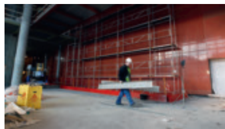
Vi snakker om heftige dimensjoner. Det letteste elementet veier 430 kilo, mens det tyngste veier 20 tonn. Noen elementer er i rødbrun granittbetong, som her.
