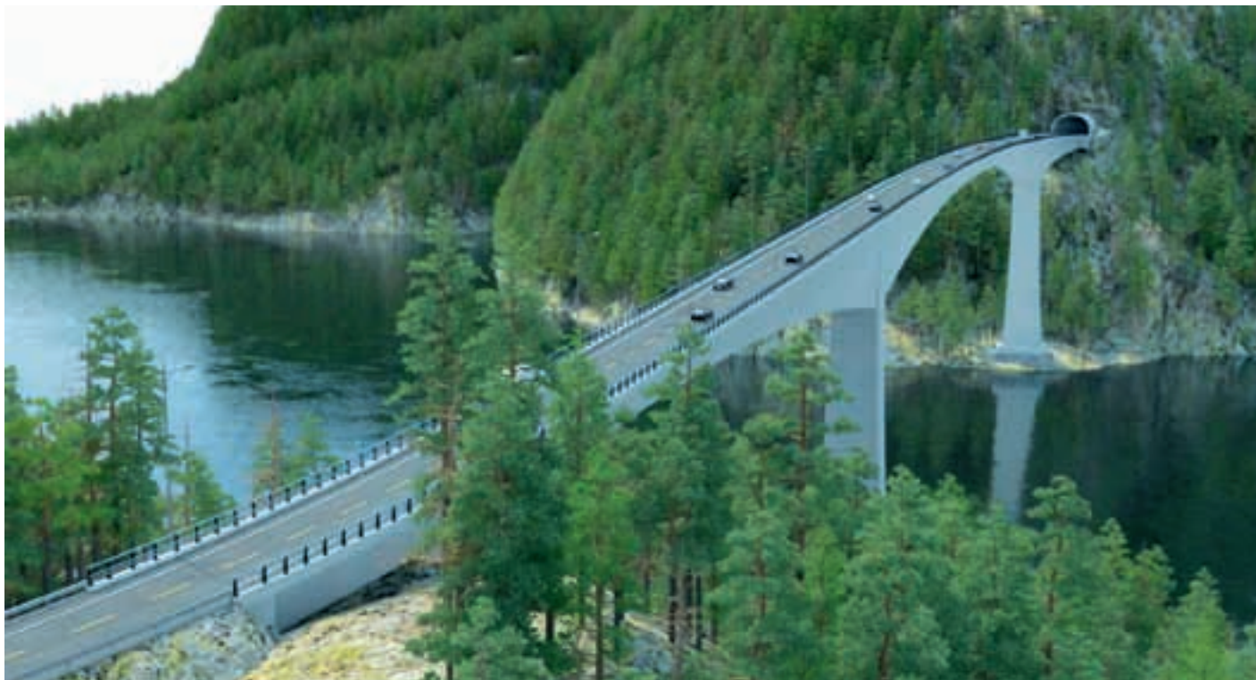
Sandsfjord bru blir 580 meter lang og får et hovedspenn på 290 meter. Prosjektet blir et viktig bidrag til næringsutviklingen, særlig i Indre Ryfylke.
