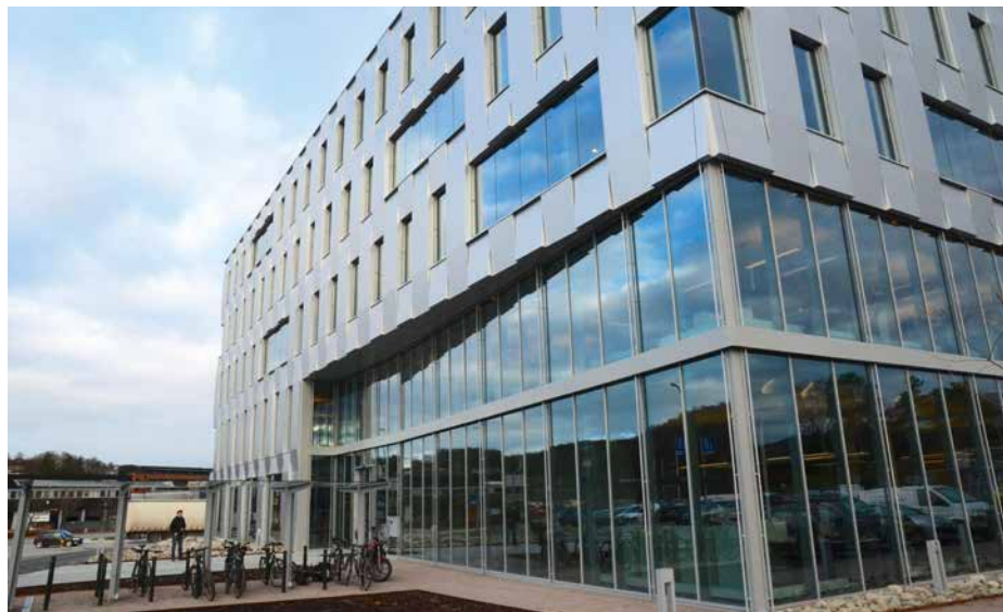
Add Energy flyttet i høst inn i det første bygget i den nye næringsparken 2020park på Forus.
