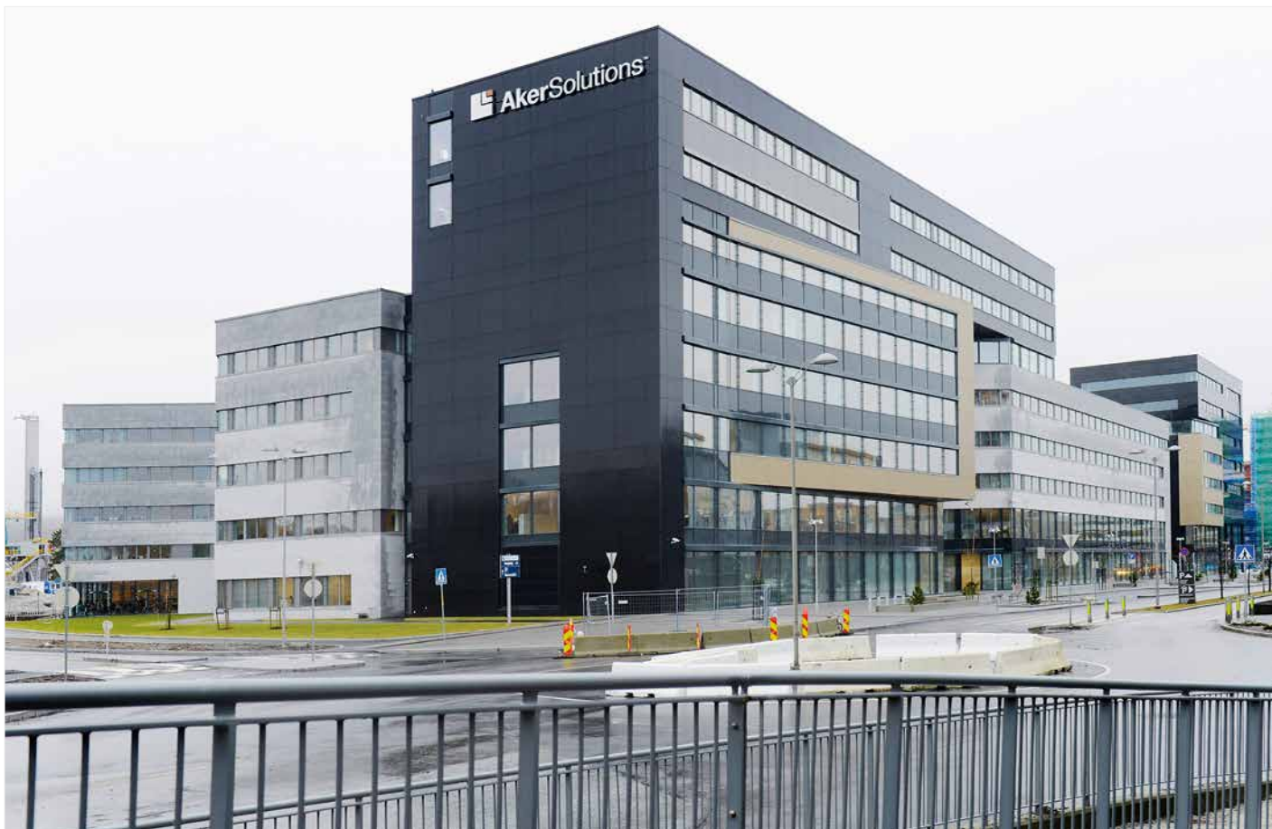
Aker Solutions' nye kontorbygg i Jåttåvågen i Stavanger huser over 2.000 ansatte. Foto: Kjetil Alsvik.
