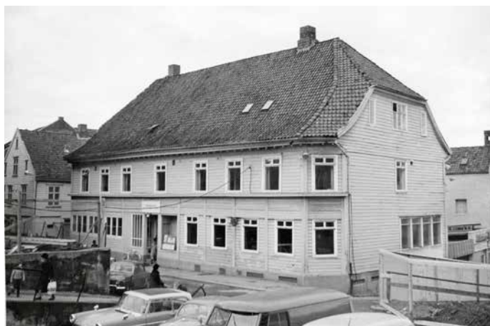
Rosenkildehuset fotografert i Nedre Strandgate rundt 1967. Til venstre ser vi restene av terrassehagen, og bilene hadde gode parkeringsmuligheter i området på den tiden. Hovedinngangen lå fortsatt på "baksiden", mens sjøsiden er helt innebygget. Fra Gunnar Warebergs arkiv, Statsarkivet i Stavanger.
