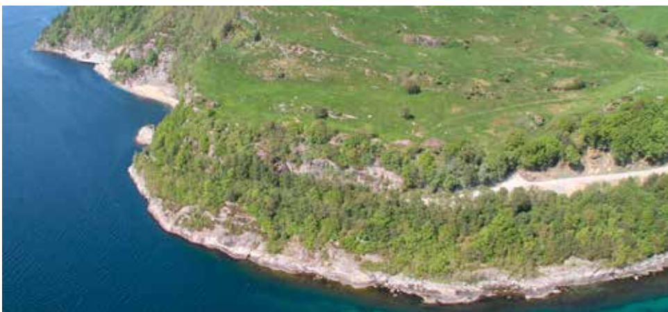
Anlegget på Rennesøy har en unik beliggenhet for et datasenter både i forhold til energi og sikkerhet.
