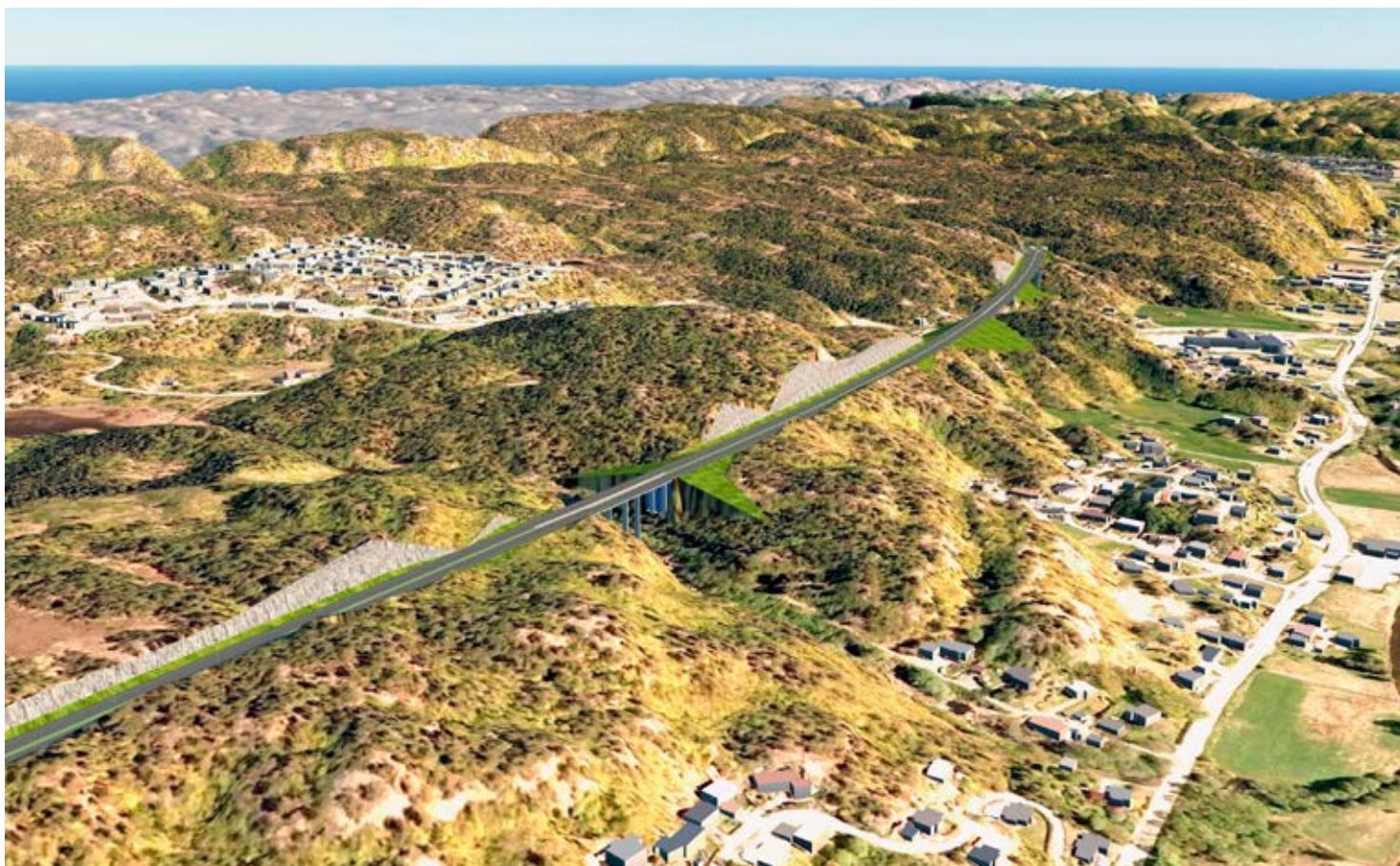
Når byggingen av ny firefelts vei mellom Stavanger og Kristiansand kan starte, er usikkert og ikke bestemt. Trolig vil det i alle fall ikke starte før 2020.
