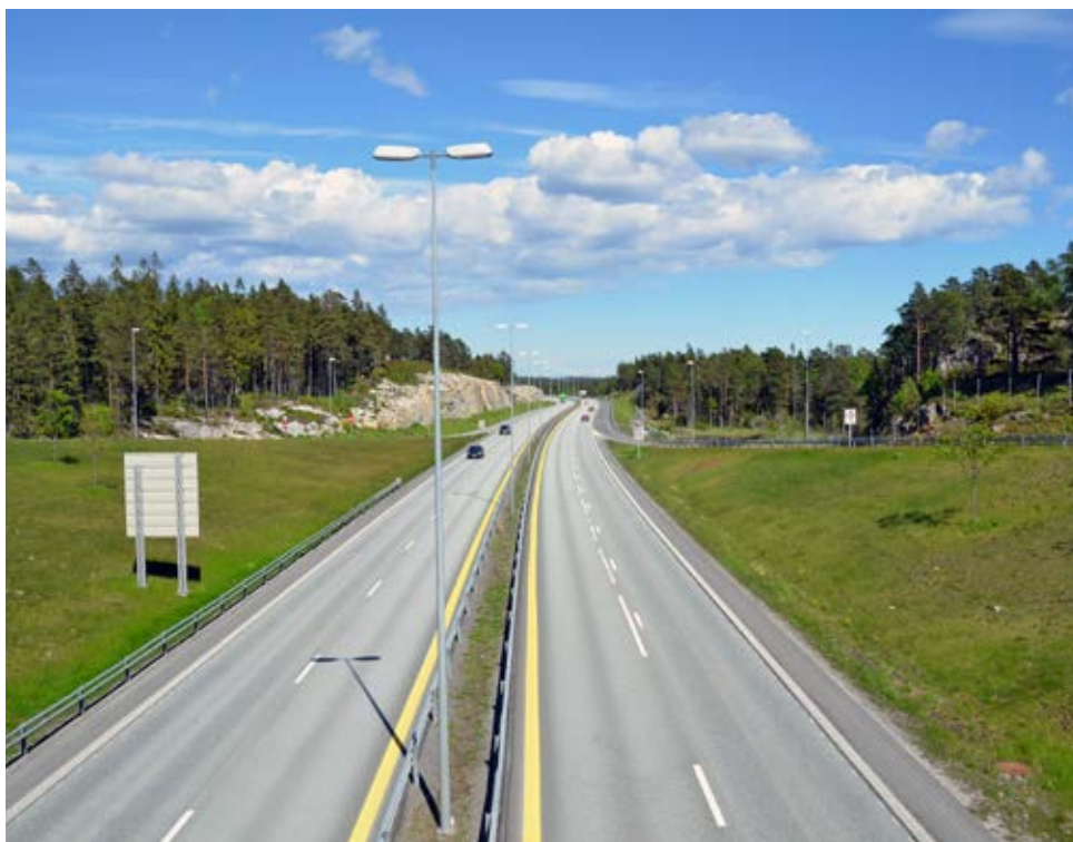
Bildet viser dagens vei fra Kristiansand mot Grimstad, med tilsvarende den standarden det planlegges for på E39. Foto: Nina Kjemperud
