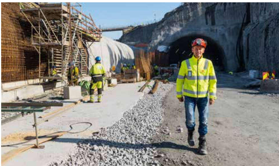
- Vi kan ikke bygge raskere enn det vi gjør nå, sier prosjektleder for Ryfast, Gunnar Eiterjord.
