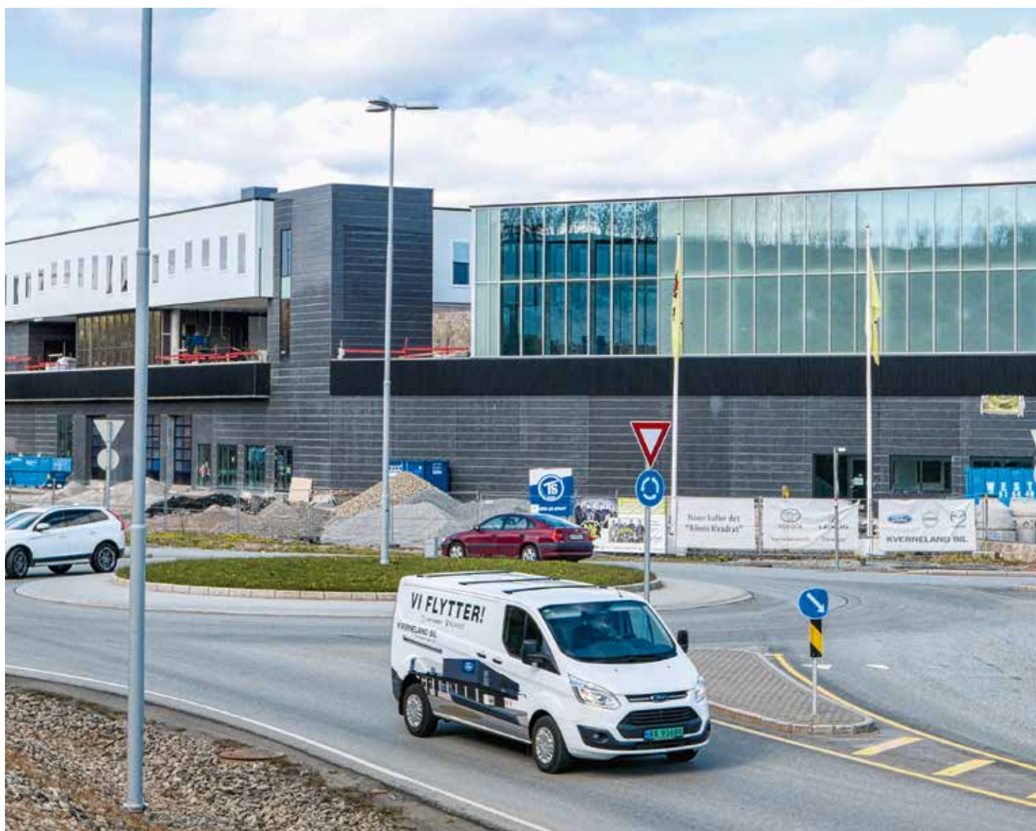
I september åpner bilhuset, men allerede nå nærmer anlegget ved Löwenstrasse på Forus seg ferdigstillelse.
