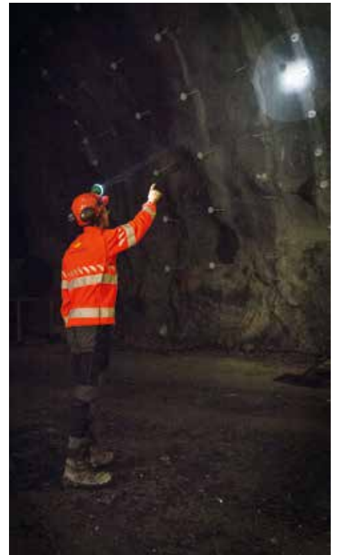
- Det blir skutt cirka 15.000 salver i forbindelse med tunnelprosjektet, fortalte Gunnar Eiterjord.
