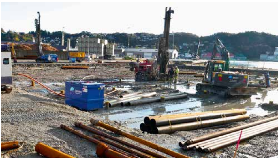
På Kaupanes bygges det et mottaksbygg for Statnett sine sjøkabler mellom Norge og Storbritannia og Norge og Tyskland. Egersund konkurrerte med en rekke havner i Norge om prosjektet, og gikk seirende ut.
