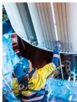
NYE KRAFTKREVENDE MULIGHETER side 22
