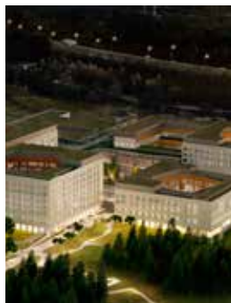
NYTT SYKEHUS GIR NYE MULIGHETER
