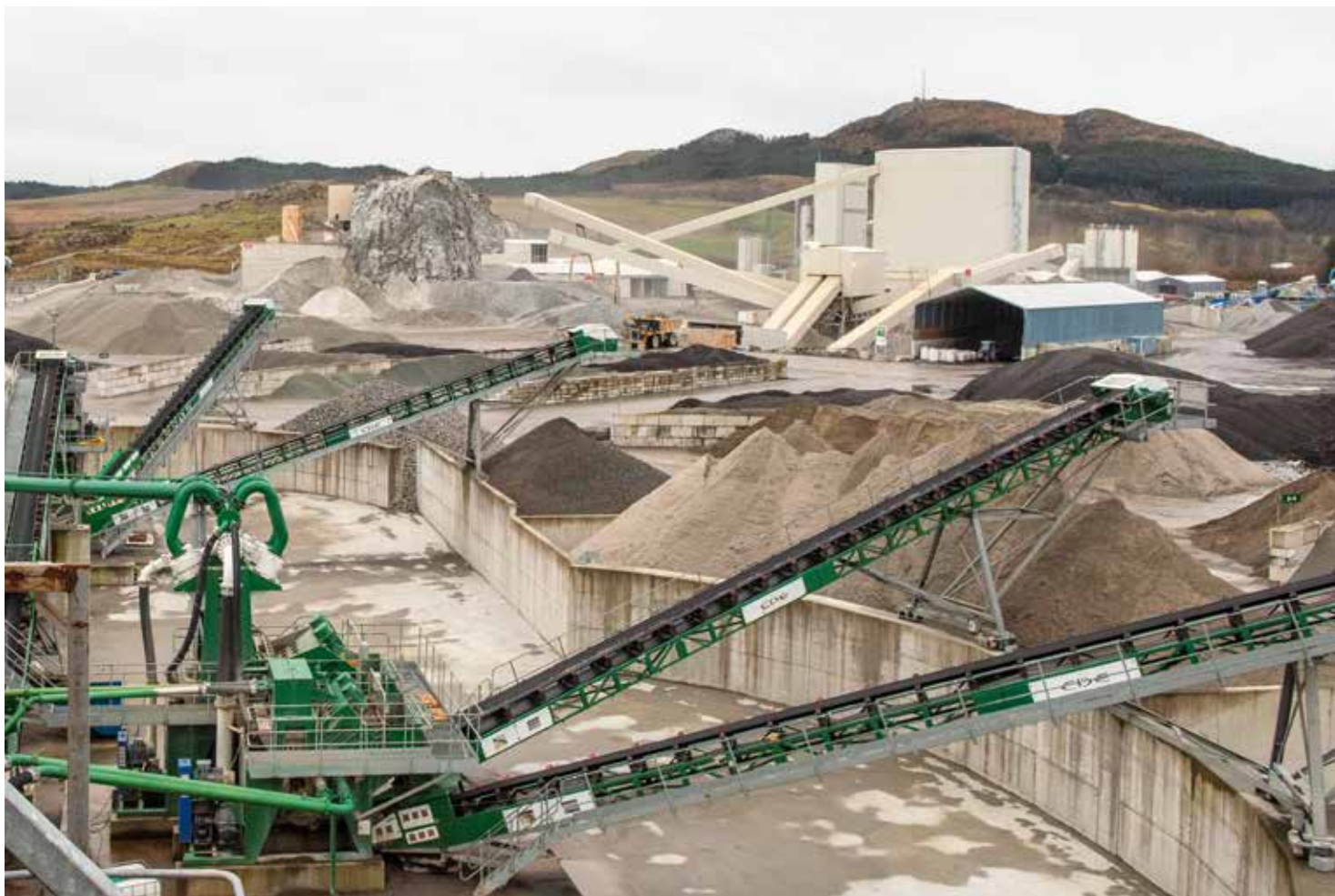
Anlegget hos Velde som renser og sorterer gjenbruksmassene.
