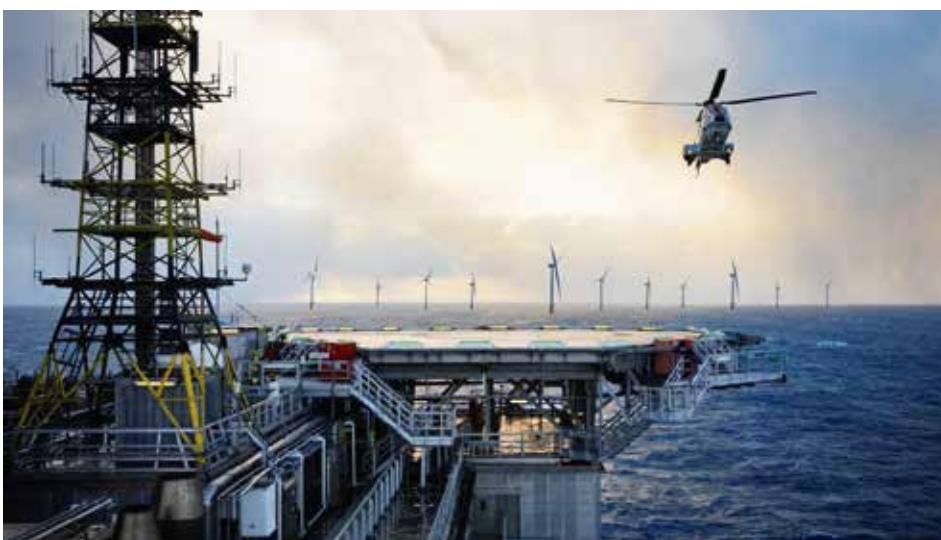
Illustrasjon av Hywind Tampen-prosjektet i Nordsjøen (Foto: Equinor)
