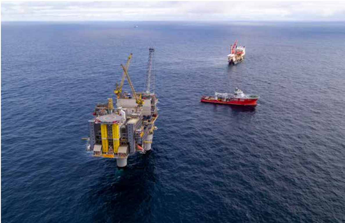
Verdens største rørleggingsfartøy legger rør mellom Troll A og de nye brønnrammene på Troll Fase 3. Prosjektet fortsetter, til tross for lav oljepris og smittevern. Foto: Øyvind Gravås/Woldcam/Equinor
