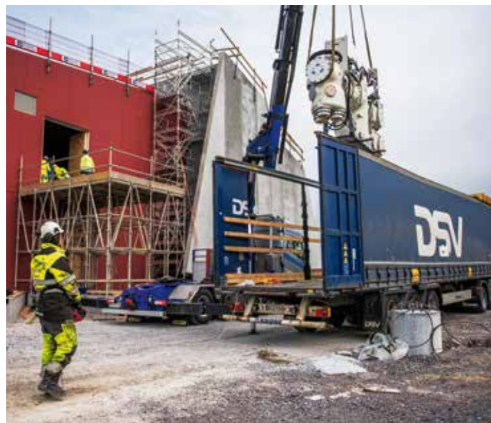
Et av prosjektene Lyse er i gang med er bygging av ny transformatorstasjon på Opstad. Før påske kom det leveranser fra Siemens i Tyskland og transformatorer fra Slovenia. Arbeidet her har fortsatt som normalt. Foto: Fredrik Ringe/Lyse
