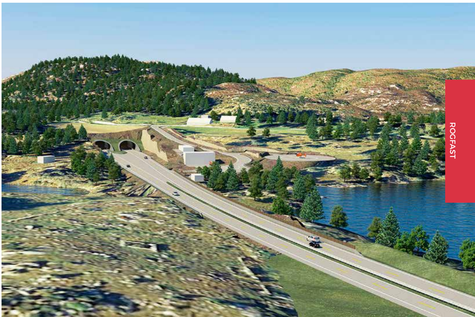
Rogfastprosjektet har i dag en kostnadsramme på 20,6 milliarder kroner. Her ved tunnelinnslaget på Bokn.
