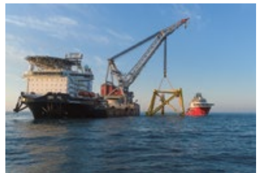
Caisson installasjon, Yme-feltet. Kunde: Repsol.
