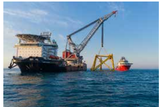
Caisson installasjon, Yme-feltet. Kunde: Repsol.
