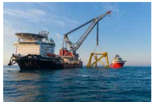
Caisson installasjon, Yme-feltet. Kunde: Repsol.
