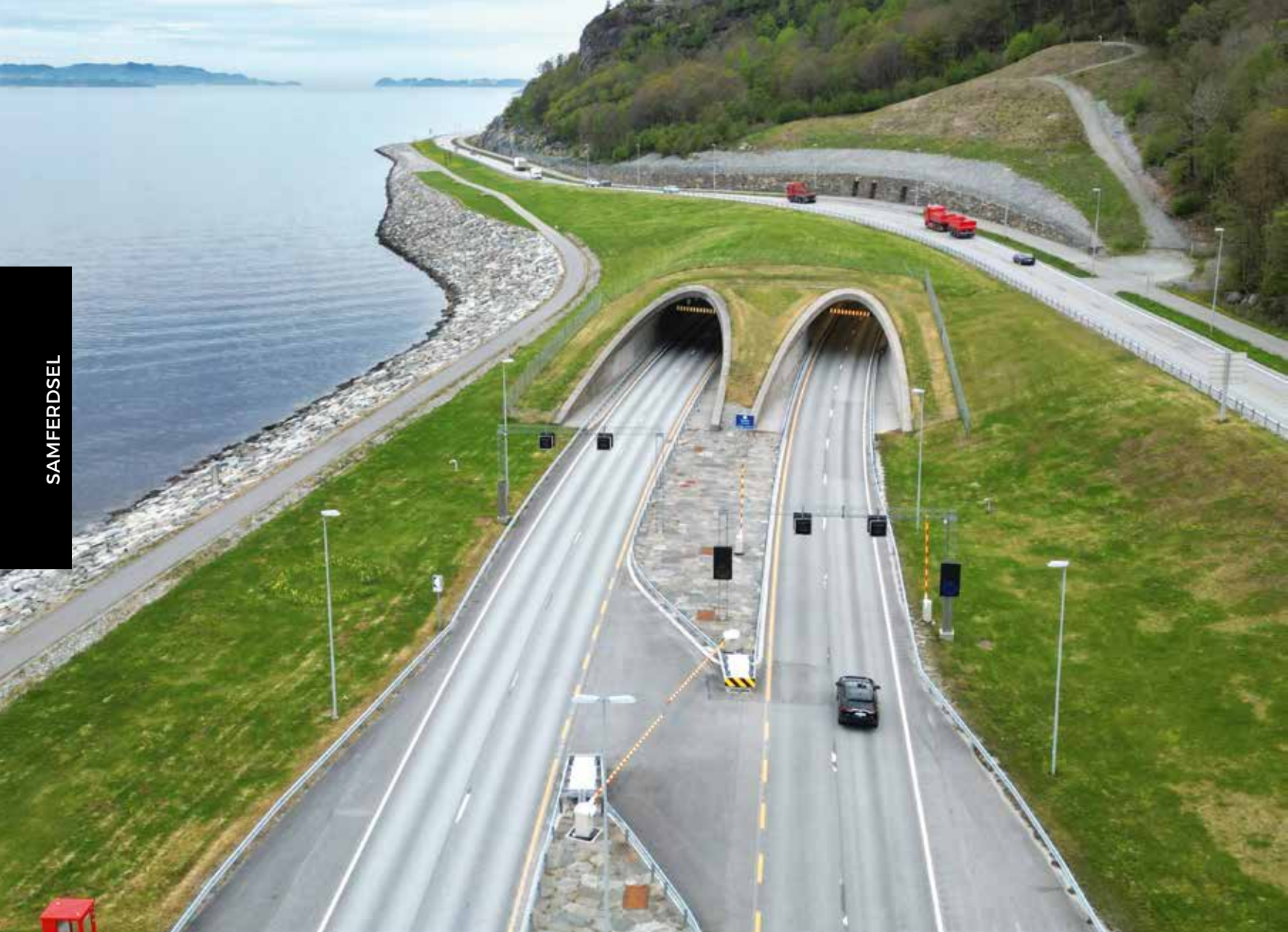
Ryfylketunnelen ble åpnet i slutten av 2019, og knytter sammen Strand og Stavanger. Statens bidrag har i realiteten vært null. Foto: Bård Asle Nordbø, Statens vegvesen.
