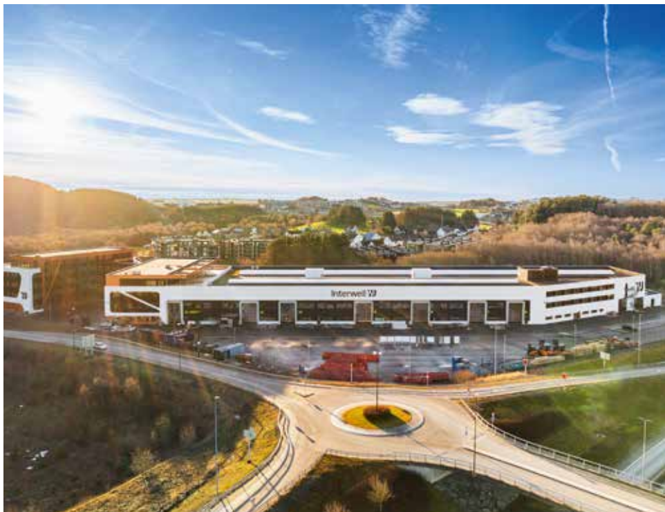
I fjor flyttet Interwell inn i nytt hovedkontor på Forus. Etter å ha vært spredt utover sju lokasjoner i distriktet er nå selskapet samlet i nytt signalbygg. Foto: Jan Rune Berge/Interwell
