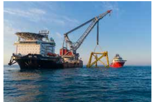
Caisson installasjon, Yme-feltet. Kunde: Repsol.
